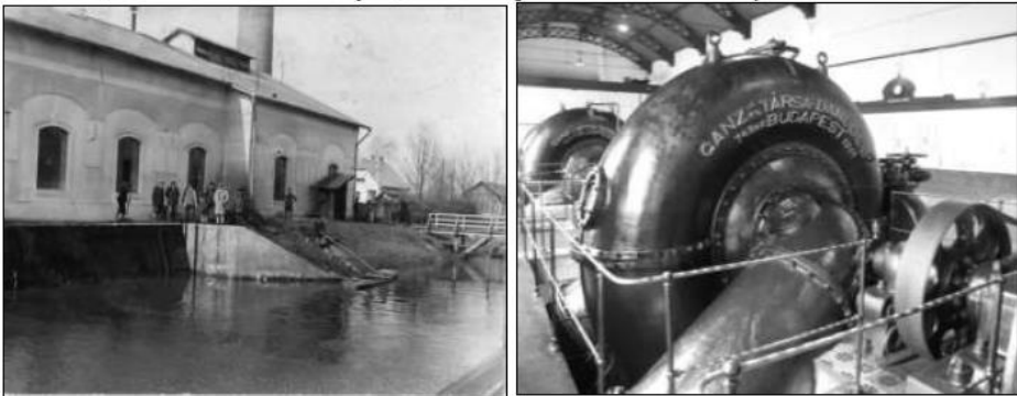
9-10. fénykép A Nagyecsed szivattyútelep épülete 1917-ben (bal) (Forrás: FTV Vízügyi Tört. Gyűjt.), a GANZ szivattyú (jobb) (Fotó: Konecsny K. 2016)
